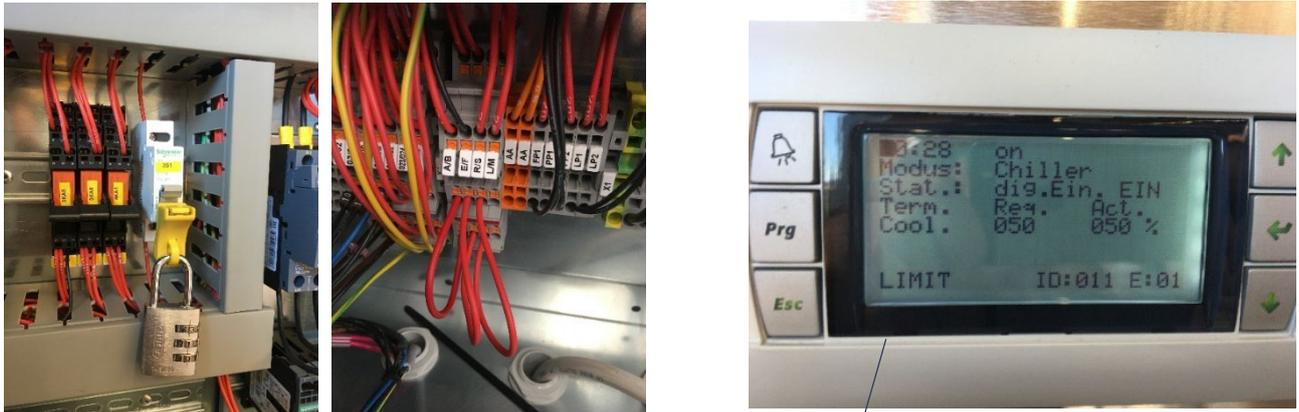
Bei reduzierter Leistung über Schalter oder Fehlen der Brücke erscheint Limit blinkend auf dem Display.
